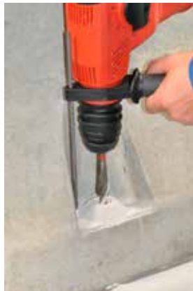
图 5b 钻固定孔
