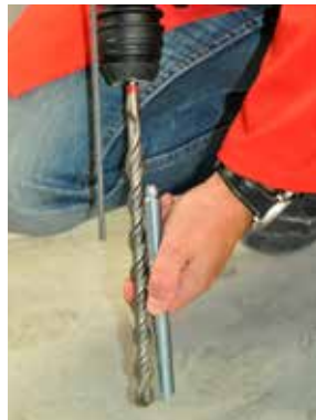
图 8b 调整钻孔深度
