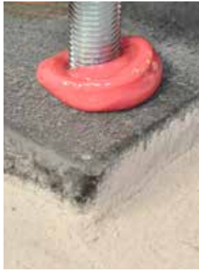
图 9b 插入螺柱
