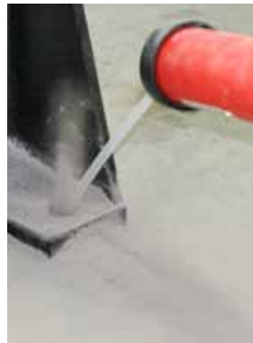
图 8c 吹扫钻孔
