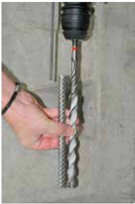
图 5a 调整钻孔深度
