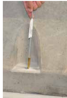
图 5d 将钻孔刷干净
