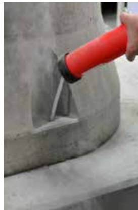
图 5c 将钻孔吹干净
