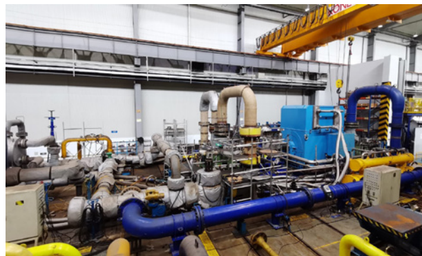
其中一个给水泵组在苏尔寿苏州生产车间接受整机测试
