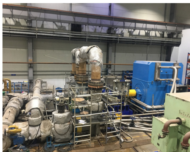
其中一个给水泵组正按照项目交付要求接受热冲击试验
