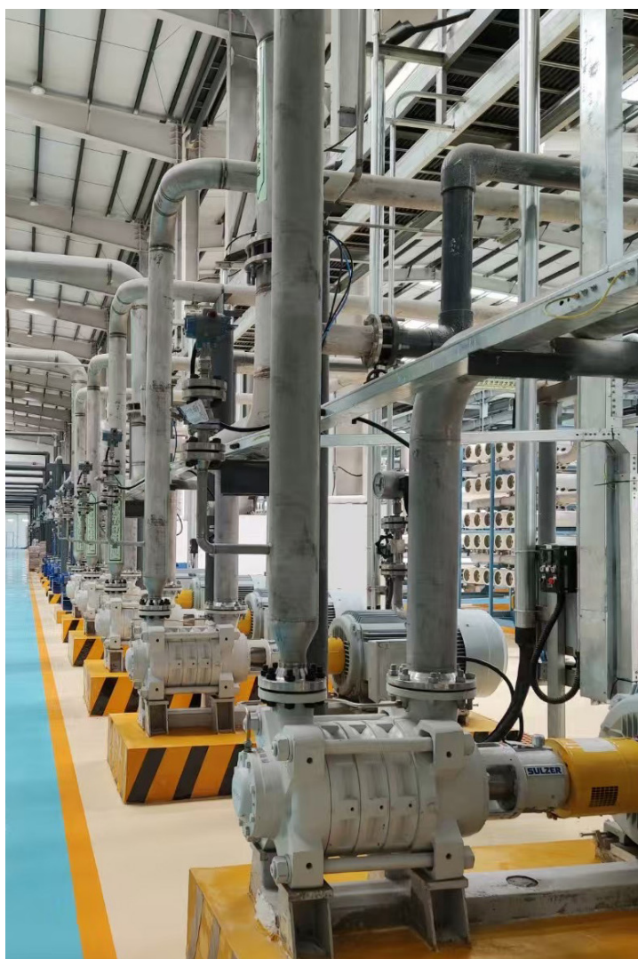
反渗透膜进料泵
