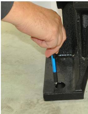
Figura 8a: Marcar los puntos de perforación
