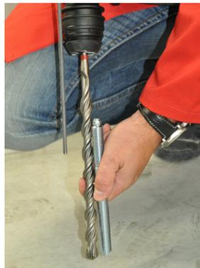
Figura 8b: Ajustar la profundidad de perforación
