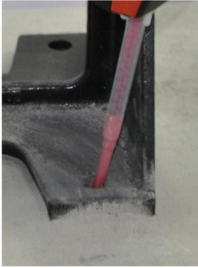
Figura 9a: Llenar mortero compuesto
