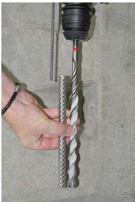
Figura 5a: Ajustar la profundidad de perforación
