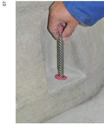
Figura 6b: Colocar la armadura
