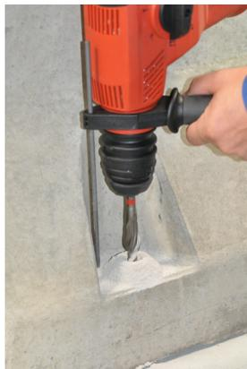
Figura 5b: Perforar los agujeros de fijación
