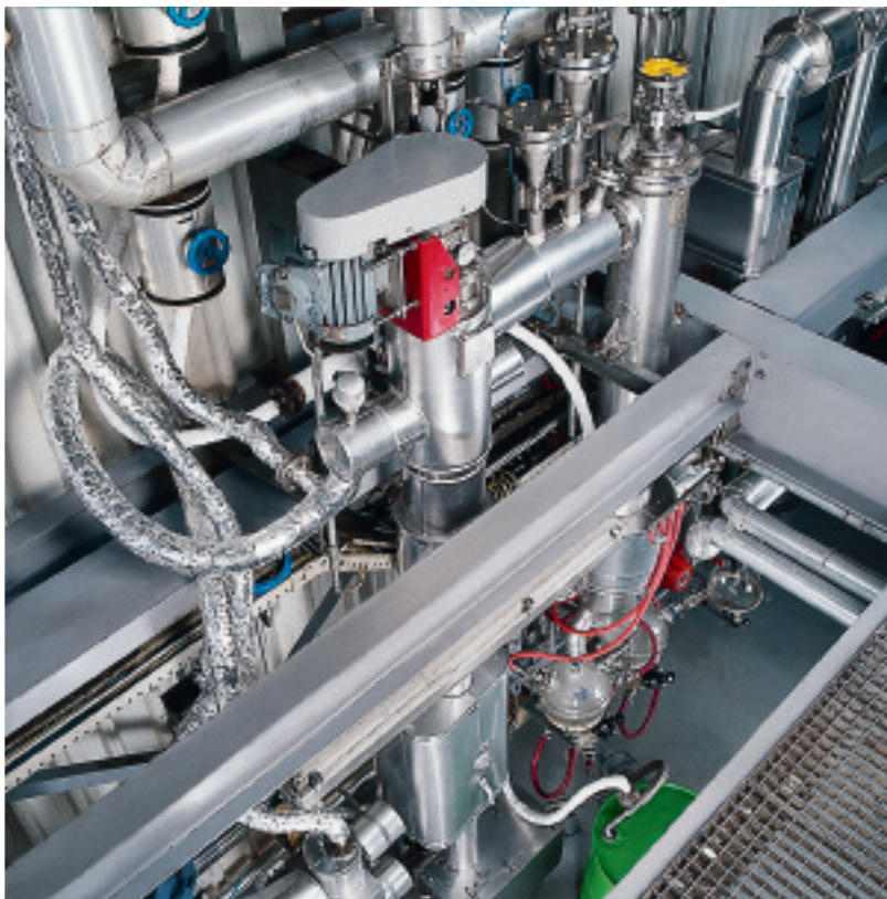
1 Dünnschichtverdampfer.
