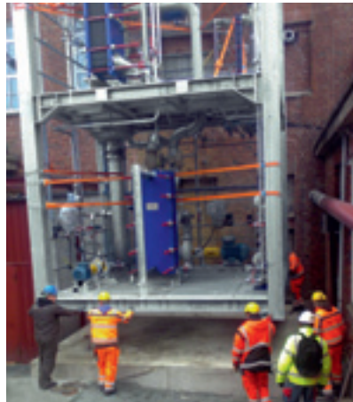
3 Aufgrund des modularen Fertigungs-konzepts erforderte die Installation des oberen und unteren Teils der Anlage in Finnland nur einen minimalen Aufwand.
