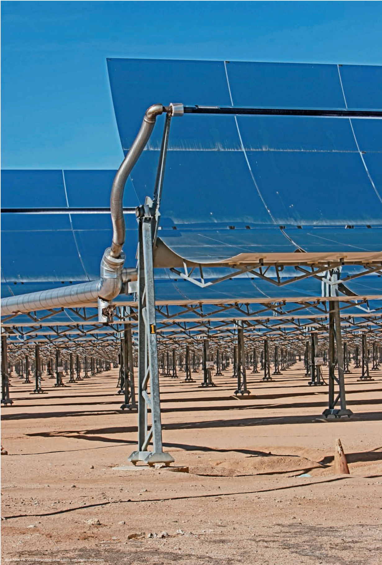
Parabolrinnen-Kraftwerk mit flexiblen Röhren zur Kompensation der Ausdehnung infolge Erwärmung.
