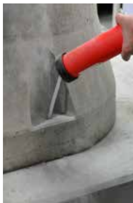
Billede 5c: Udblæsning af boring
