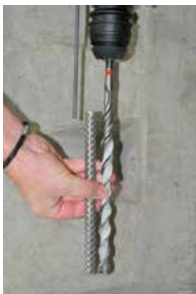
Billede 5a: Indstilling af boreddybde
