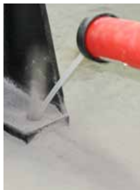
Billede 8c: Udblæsning af borehullet
