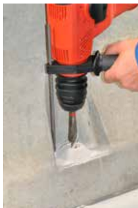
Billede 5b: Boring af fikseringshuller
