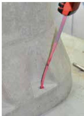
Billede 6a: Påfyldning af mørtel
