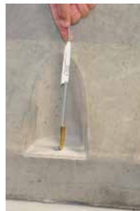
Billede 5d: Udbørstning af boring
