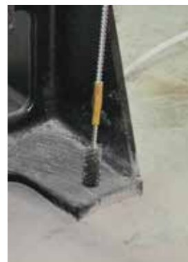
Billede 8d: Rensning af borehullet
