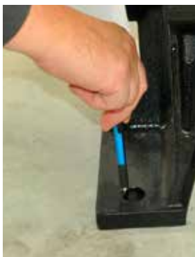
Billede 8a: Markering af borehullerne
