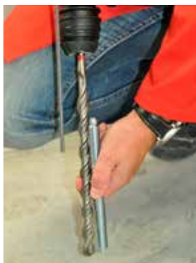
Billede 8b: Indstilling af boreddybde
