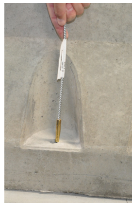
Изображение 5d: Изчеткване на отворите
