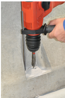
Изображение 5b: Пробиване на монтажните отвори
