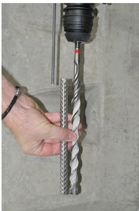
Изображение 5а: Нагласяне на дълбочината на пробиване
