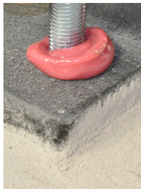
Изображение 9b: Вкарване на щифта
