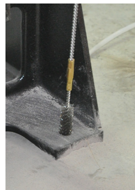
Изображение 8d: Почистване на отвора
