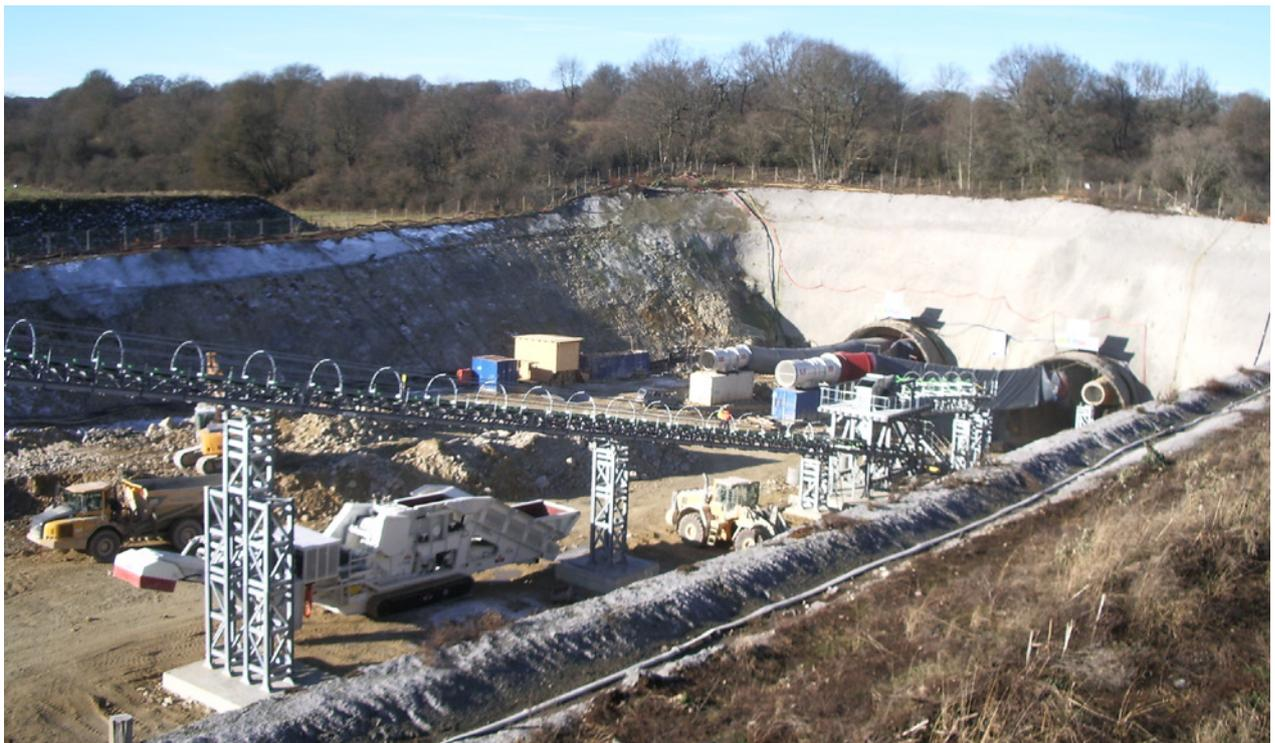
sumergibles transportables para las distintas fases de construcción, y de condiciones geológicas y climáticas. Sulzer ha suministrado hasta el momento casi cien bombas de distintos modelos y proporcionado bombas en régimen de alquiler a las obras de cuatro túneles del proyecto.
