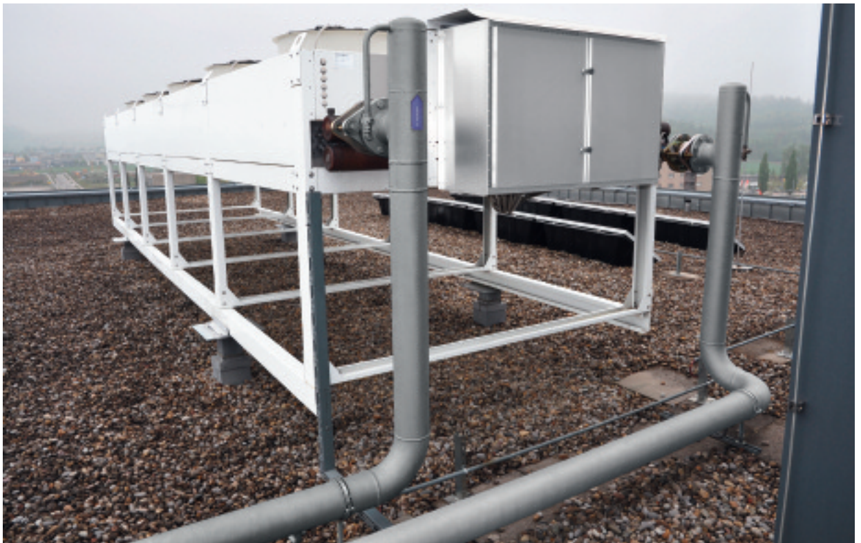
1 Abbildung eines in der Industrie eingesetzten Kühlkreislauftes.
