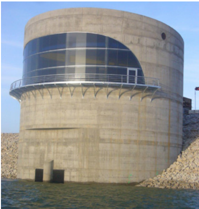
Edificio de la estación de bombeo
