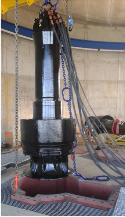
AFLX iniciando su descenso en la tubería
