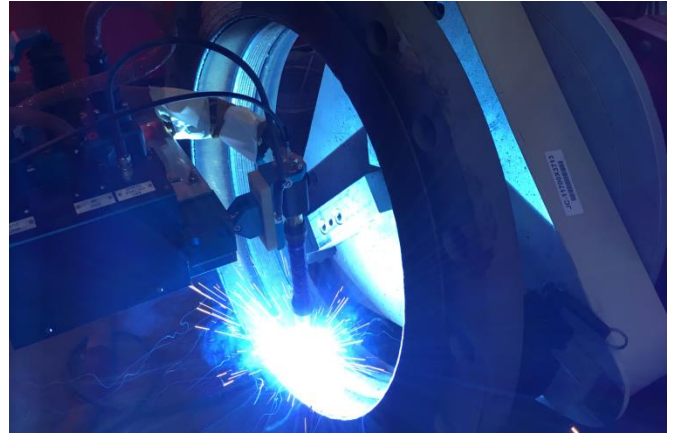
Bild 2: Stutzenerneuerung mit automatisiertem Auftragschweißen
