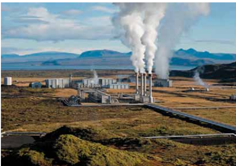
4 Das geothermische Kraftwerk Nesjavellir auf Island.
