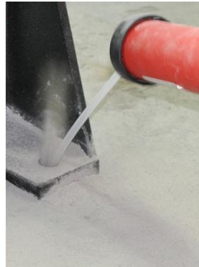
Figura 8c: Soffiare aria nel foro.
