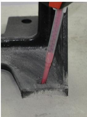
Figura 9a: Riempire con malta di fissaggio.
