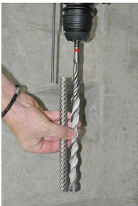
Figura 5a: Impostare la profondità di perforazione.
