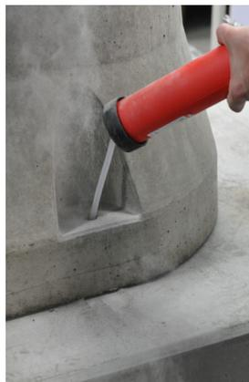
Figura 5c: Pulire il foro soffiando aria.
