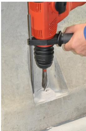
Figura 5b: Realizzare i fori di fissaggio.
