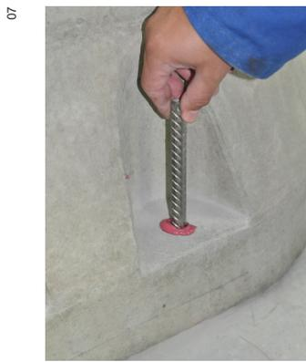
Figura 6b: Inserire l'armatura
