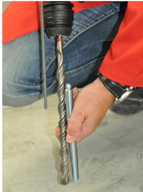
Figura 8b: Impostare la profondità di perforazione.
