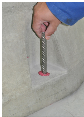
Kuva 6b: Työnnä harjateräs sisään
