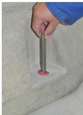
Kuva 6b: Työnnä harjateräs sisään
