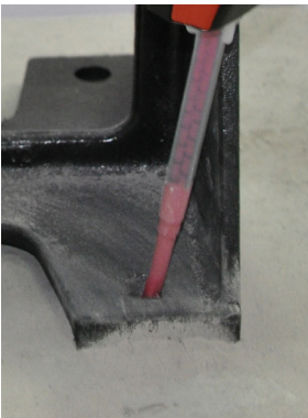
Kuva 9a: Täytä injektiomassa
