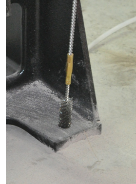
Kuva 8d: Puhdista reikä
