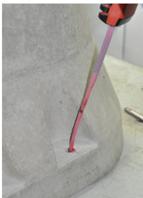
Kuva 6a: Täytä injektiomassa
