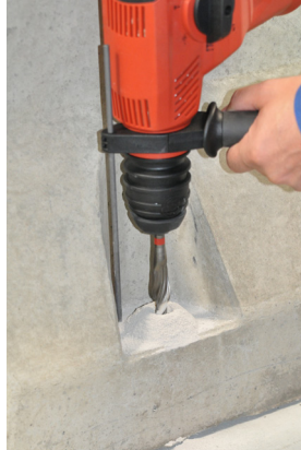
Kuva 5b: Pora kiinnitysreiät
