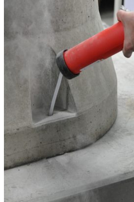
Kuva 5c: Puhalla reikä puhtaaksi
