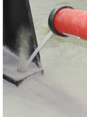
Kuva 8c: Puhalla reikä puhtaaksi
