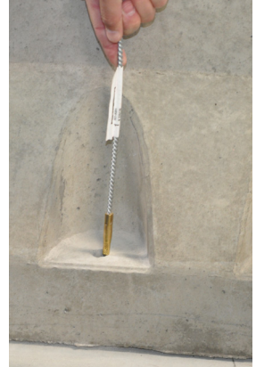
Kuva 5d: Harjaa reikä puhtaaksi
