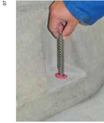
Figura 6b: Colocar la armadura
