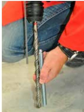
Figura 8b: Ajustar la profundidad de perforación
