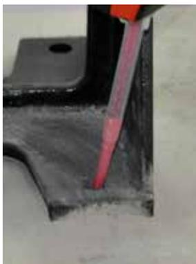
Figura 9a: Llenar mortero compuesto
