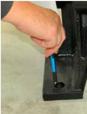
Figura 8a: Marcar los puntos de perforación
