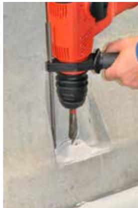
Figura 5b: Perforar los agujeros de fijación
