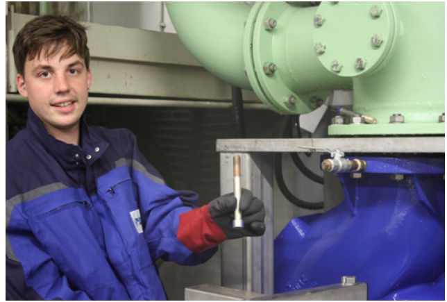
Für die Wartung reicht es, die sechs Schrauben zwischen Motor und Kreiselkammer zu lösen.
