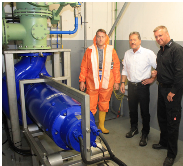
Sulzer Abwasserpumpe Baureihe XFP mit Wartungsschlitten
