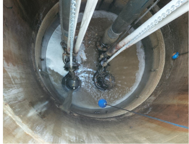
Vista desde la parte superior del pozo. Condiciones especialmente complicadas, ya que el agua entraba cayendo directamente sobre la bomba.
