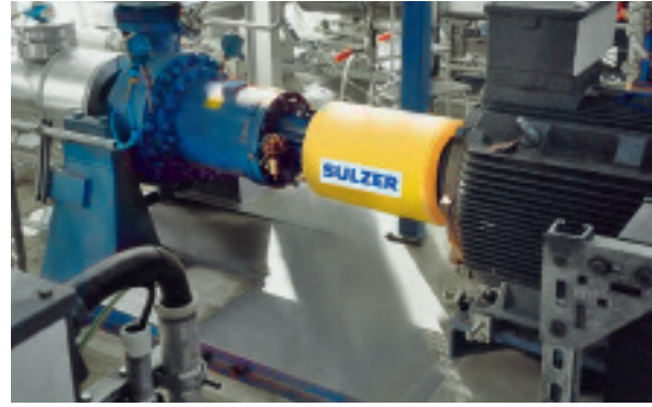
Dichtungslose ZEM/OHM-Pumpen als Hilfsumwälzpumpen für das Wärmeträgerfluid.
