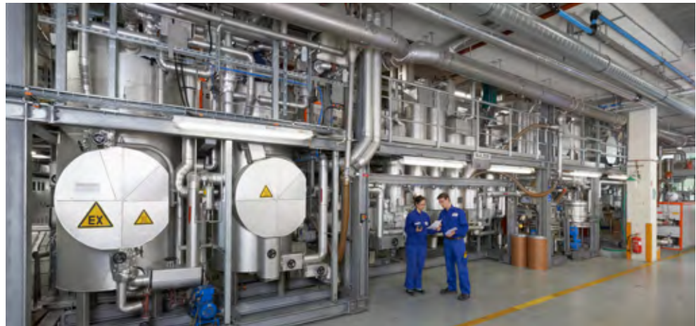
Abb. 4 Sulzer zur Herstellung von PLA.
