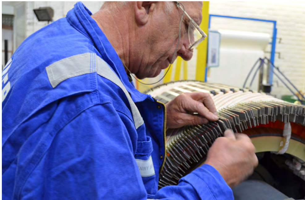
Fig. 4 Die beschädigten Komponenten wurden neu gewickelt, während die Ursache untersucht wurde.
