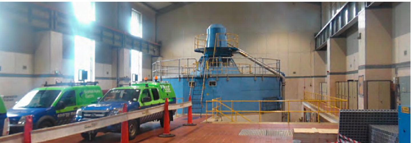
1 Die Reparatur des Stators erfolgte vor Ort im Kraftwerk Inverawe.
