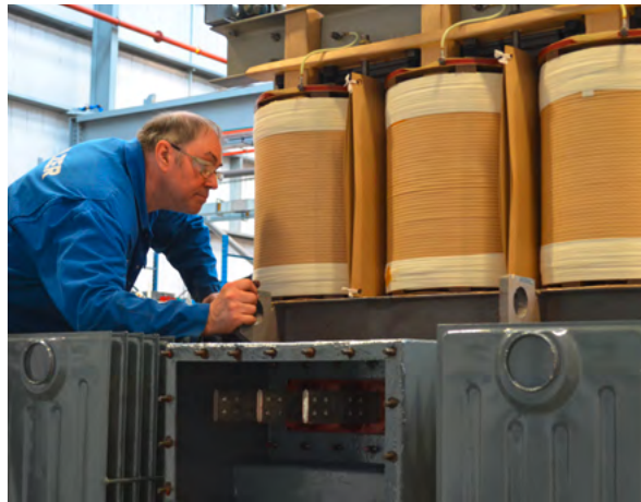
3 Qualitätsprüfung des instand gesetzten Transformators.
