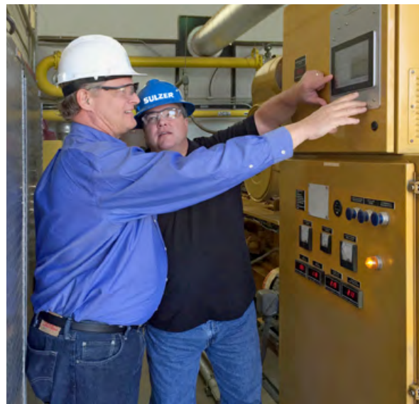
3 Programmierung des Luft-Kraftstoff-Gemischreglers EPC-250.
