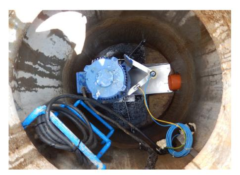
Die Sulzer-Ingenieure empfahlen einen langsam laufenden Zerkleinerer vom Typ Muffin Monster 10K und zwei Abwasserpumpen vom Typ Piranha mit dem einzigartigen Sulzer-Schneidsystem zur weiteren Zerkleinerung der Feststoffe und zum Druckaufbau für die Ableitung der Abwässer.
