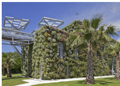
Aquaviva, une station d'épuration innovante qui répond aux exigences du Grenelle de l'environnement
