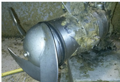
Vue de l'agitateur sur son kit pour inspection après 6 mois de fonctionnement
