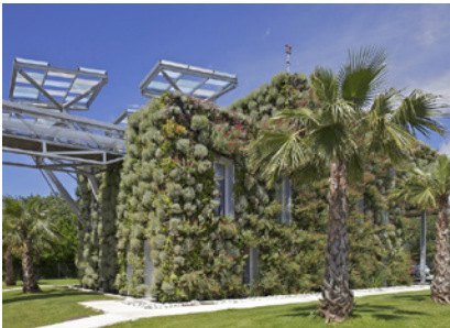
Aquaviva, eine innovative Abwasserreinigungsanlage welche die Anforderungen des Grenelle Environment Standards erfüllt.
