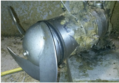
Begutachtung nach 6 Monaten Betrieb.
