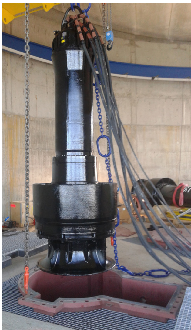
AFLX iniciando su descenso en la tubería
