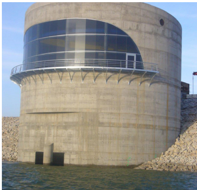
Edificio de la estación de bombeo
