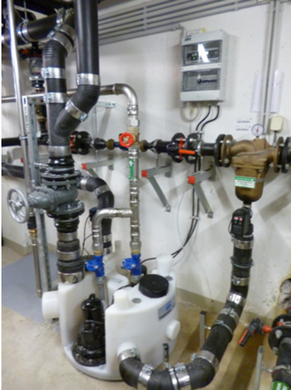
Piranhamat 1002 D, 25 m tief unter der „Erde“
