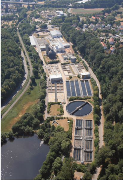
The sewage treatment plant of Stadtentwässerung Kaiserslautern
