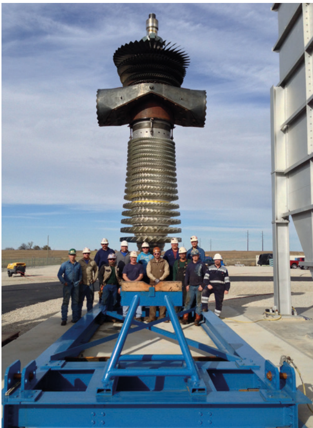
El Field Services team se prepara para instalar un rotor de turbina de gas tras un reacondicionamiento
