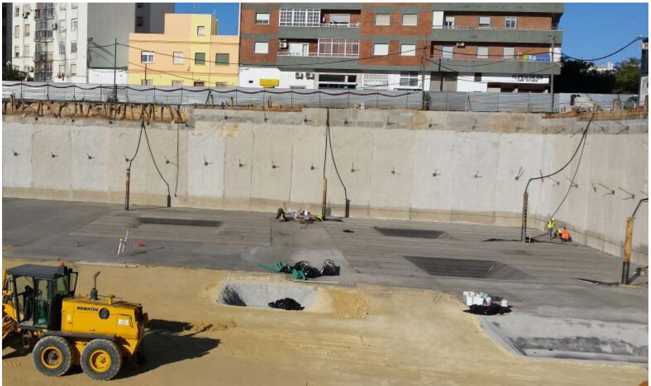
Construcción a un metro por debajo del nivel freático
