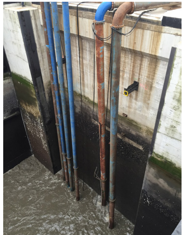
Mietpumpeneinsatz im Schleusenbecken. Zu sehen ist die parallele Installation der 6 Flanschrohre inklusive Bögen
