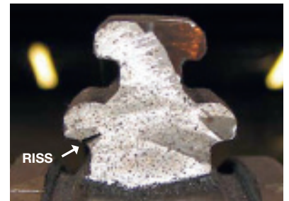
2 Typische Rissposition an den Verbindungszapfen. Die Risse verliefen um das gesamte Laufrad.
