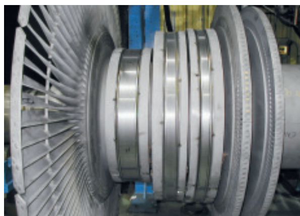
7 Die Stufen T12, T14 und T15 bei der Vorbereitung mit teilweise installierten «Weld-off-Ringen» und Thermo-elementen zur Temperaturüberwachung.
