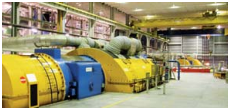
5 Blick auf beide Einheiten nach der mechanischen Fertigstellung.
