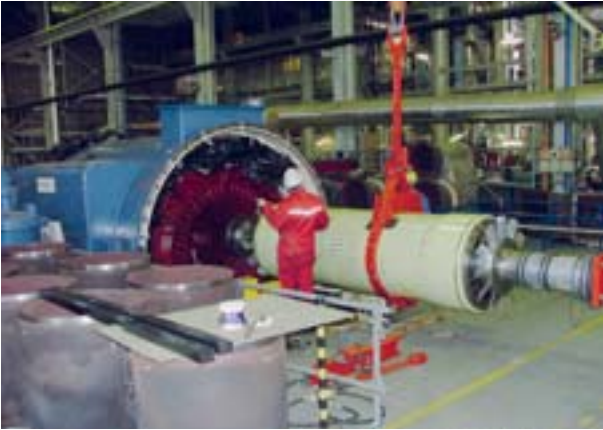
4 Ausbau des Generator-Rotors.
