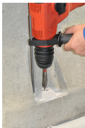
Obrázek 5b: Vrtání upevňovacích otvorů
