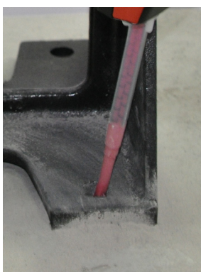
Obrázek 9a: Plnění spojovací malty
