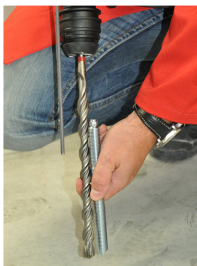
Obrázek 8b: Nastavení hloubky vrtání
