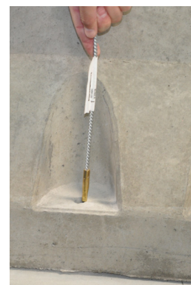
Obrázek 5d: Vykartáčování otvoru
