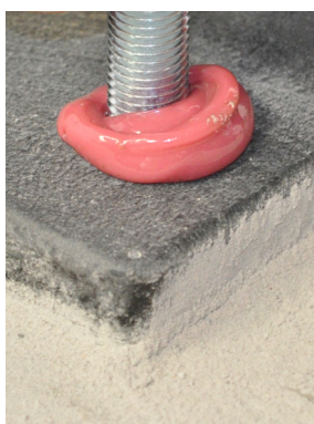
Obrázek 9b: Zavedení kolíku
