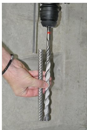
Obrázek 5a: Nastavení hloubky vrtání
