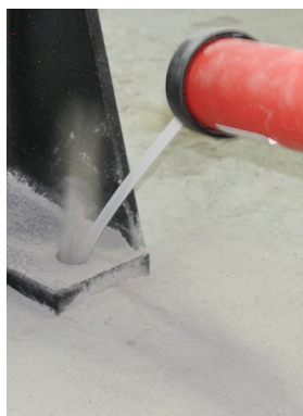
Obrázek 8c: Vyfoukání vyvrtaného otvoru
