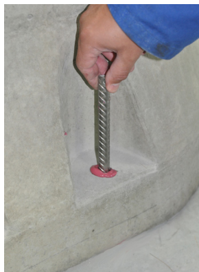
Obrázek 6b: Nasazení výztuže
