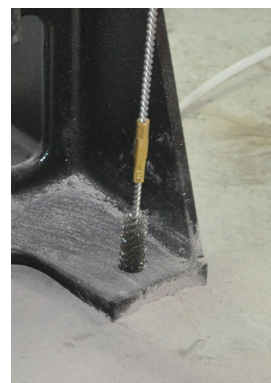
Obrázek 8d: Vyčištění vyvrtaného otvoru
