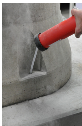
Obrázek 5c: Vyfoukání otvoru
