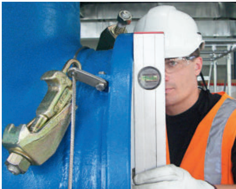
Ein Kundendienstmitarbeiter von Sulzer überwacht die Installation neuer Ausrüstung am Kundenstandort.
