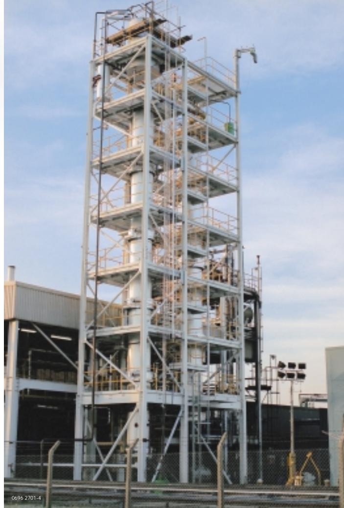
4 ■ Nach erfolgreichen Pilotversuchen vor Ort an der bestehenden Polystyrolanlage plante und lieferte Sulzer Chemtech das zusätzliche Reaktorvolumen, mit dem die vom Kunden gewünschte Kapazitätssteigerung erzielt werden konnte.
