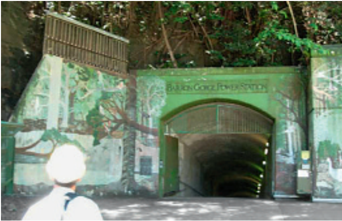
2 Zugang zu den unterirdischen Generatoren des Barron-Gorge-Kraftwerks in Queensland, Australien.
