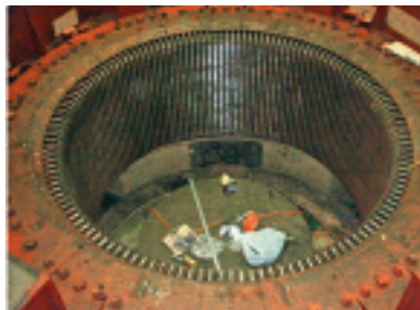
b) Demontage der ursprünglichen Wicklung
