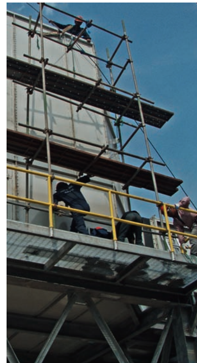
8 Montage des Lufteinlasssystems vor Ort.
