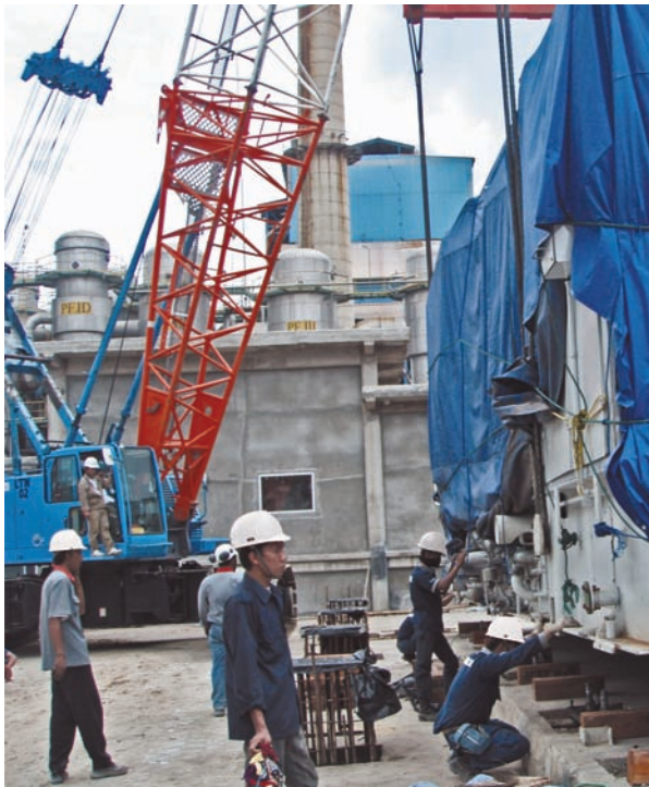
6 Die Gasturbineinheit wird zur Vorausrichtung direkt auf das Fundament abgeladen.
