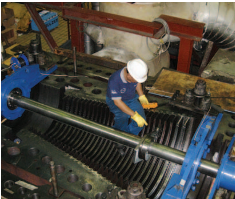
4 Vor-Ort-Endbearbeitung der Stator Komponenten der HD-Turbine.
