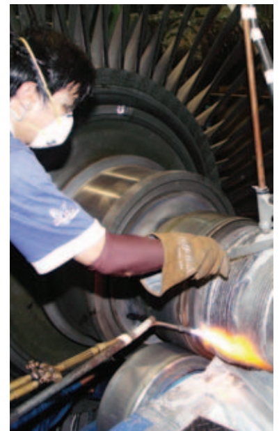
2 Schweißen am Radiallager des ND-Rotors.
