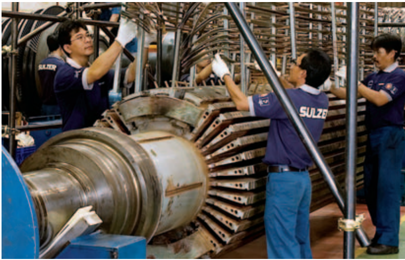
3 Neuwicklung des Generators.
