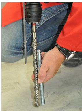
Εικόνα 8b: Ρύθμιση του βάθους διάτρησης
