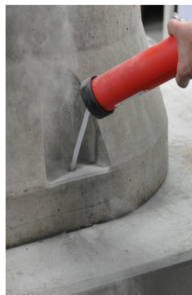
Εικόνα 5c: Καθαρισμός των οπών με πεπιεσμένο αέρα
