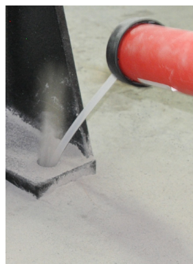
Εικόνα 8c: Καθαρισμός των οπών με πεπιεσμένο αέρα
