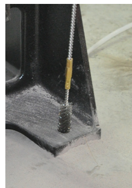
Εικόνα 8d: Καθαρισμός οπής
