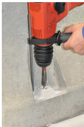
Εικόνα 5b: Διάνοιξη των οπών στερέωσης
