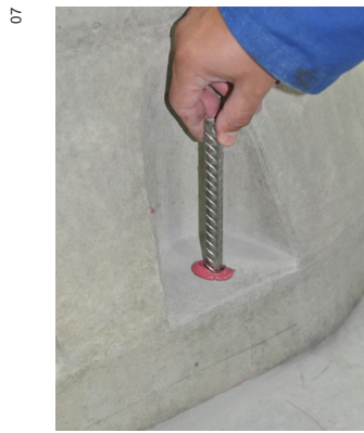
Εικόνα 6b: Τοποθέτηση του οπλισμού
