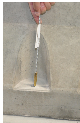
Εικόνα 5d: Βούρτσισμα της οπής
