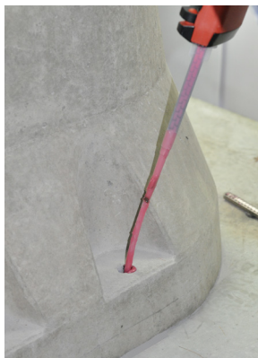
Εικόνα 6a: Πλήρωση με κονίαμα
