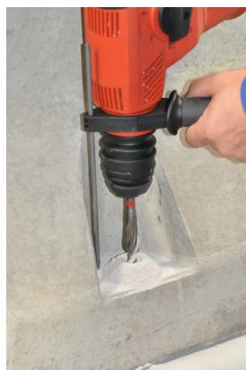
Billede 5b: Boring af fikseringshuller
