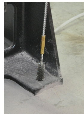
Billede 8d: Rensning af borehullet
