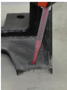
Billede 9a: Påfyldning af mørtel
