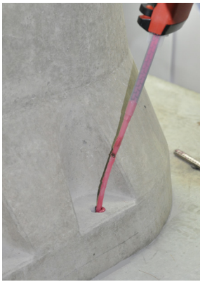
Billede 6a: Påfyldning af mørtel
