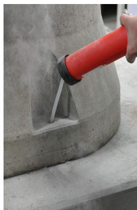
Billede 5c: Udblæsning af boring
