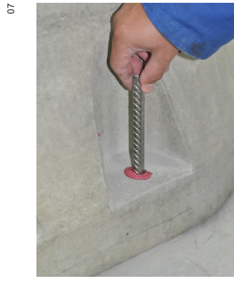
Billede 6b: Placering af armering
