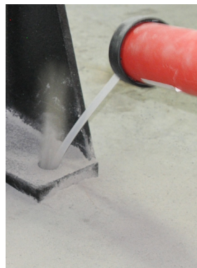
Billede 8c: Udblæsning af borehullet
