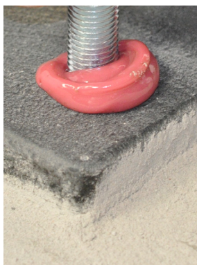
Billede 9b: Placering af bolt
