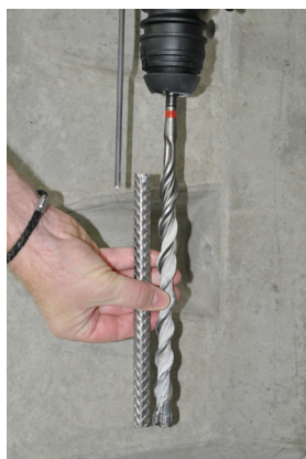
Billede 5a: Indstilling af boreddybde
