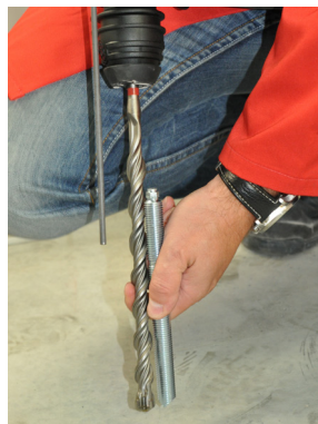
Billede 8b: Indstilling af boreddybde
