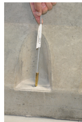
Billede 5d: Udbørstning af boring
