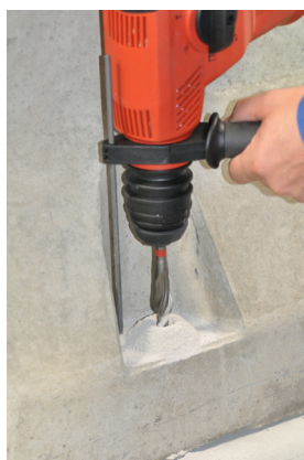
Imagem 5b: Fazer furos de fixação
