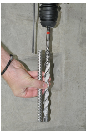
Imagem 5a: Ajustar a profundidade de perfuração
