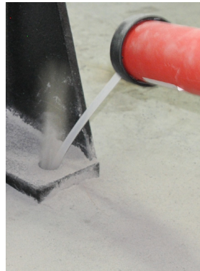
Imagem 8c: Soprar o orifício de perfuração
