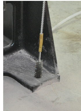
Imagem 8d: Limpar o orifício de perfuração
