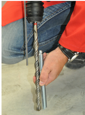
Imagem 8b: Ajustar a profundidade de perfuração
