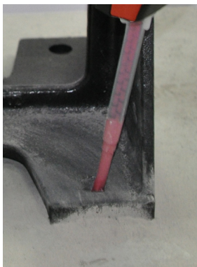
Imagem 9a: Encher com argamassa química
