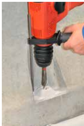
Изображение 5б: Пробиване на монтажните отвори
