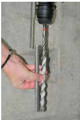
Изображение 5а: Нагласяне на дълбочината на пробиване
