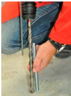
Изображение 8b: Нагласяне на дълбочината на пробиване
