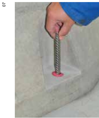
Изображение 6б: поставяне на арматурата
