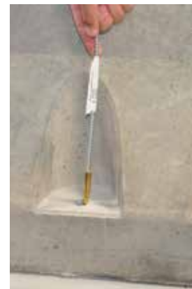
Изображение 5д: Изчеткване на отворите
