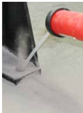
Изображение 8c: Продухване на отвора
