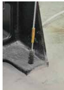
Изображение 8d: Почистване на отвора
