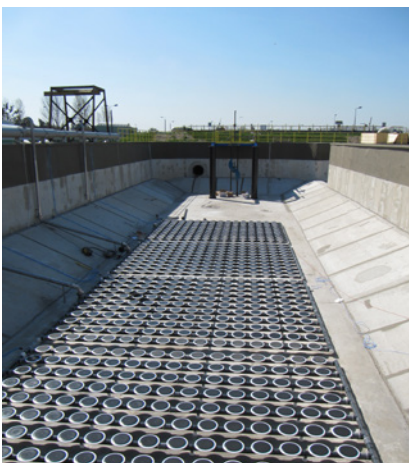
Tellerbelüftungssystem basierend auf feinblasigen Belüftern
