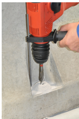
Изображение 5b: Пробиване на монтажните отвори
