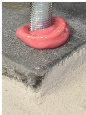
Изображение 9b: Вкарване на щифта
