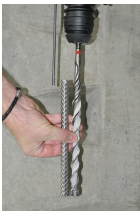
Изображение 5а: Нагласяне на дълбочината на пробиване
