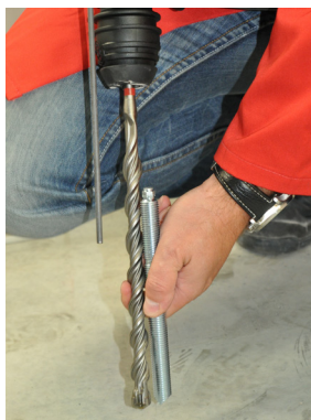
Изображение 8b: Нагласяне на дълбочината на пробиване
