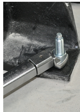
Изображение 9d: Затягане на гайката
