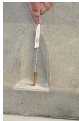
Изображение 5d: Изчеткване на отворите
