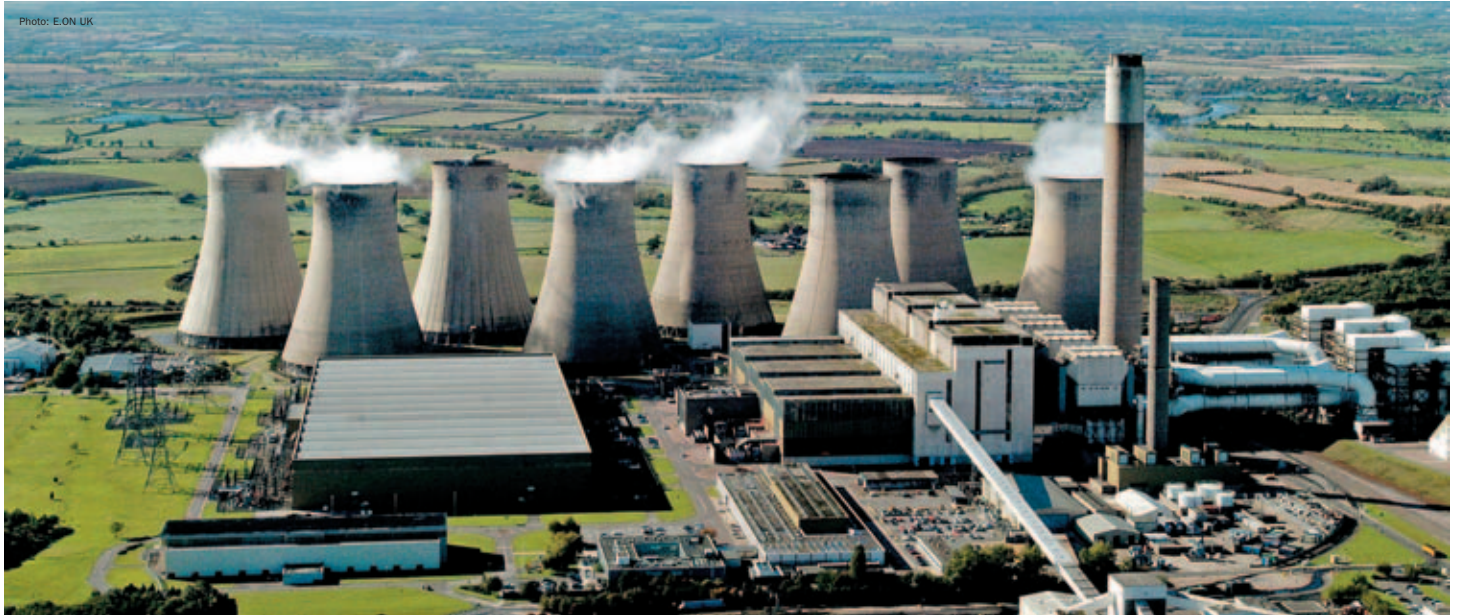
Das 1968 in Betrieb genommene Kraftwerk Radcliffe-on-Soar hat eine markante Lage im Tal des River Trent in Nottinghamshire, England. Das Kraftwerk umfasst vier kohlebefeuerte Kessel und hat eine Gesamtleistung von über 2000 MW.
